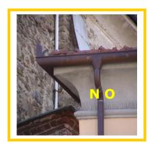
I terminali esterni dei pluviali dovranno essere in ghisa del tipo tradizionale; se il pluviale, nella parte terminale, è incassato nella muratura, la parte murata deve essere realizzata in materiale plastico (tipo GEBERIT) al fine di evitare condense che macchierebbero il muro, oppure il terminale deve essere inserito in una scanalatura aperta per consentirne l'aerazione naturale.
