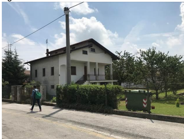
Area e fabbricato esistente in area 3 R4
